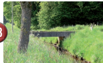
Brücke an der Leygraaf
