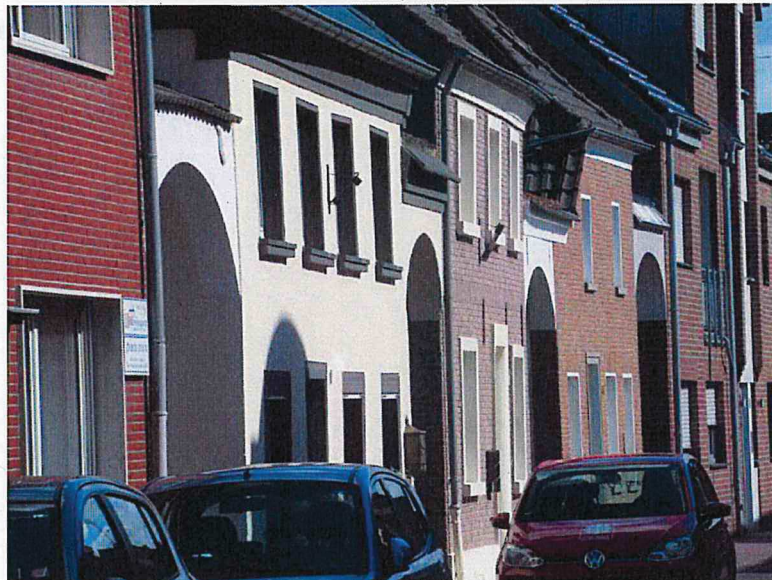
12: Rheurder Straße, rhythmischer Wechsel von zweigeschossigen Bauten mit glatten Lochfassaden und Toreinfahrten.
