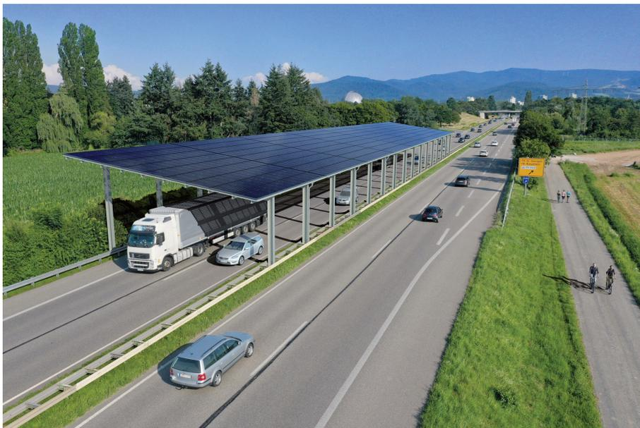
Abbildung 34: Visualisierung einer bifazialen PV-Anlage über einer Autobahn © Fraunhofer ISE
