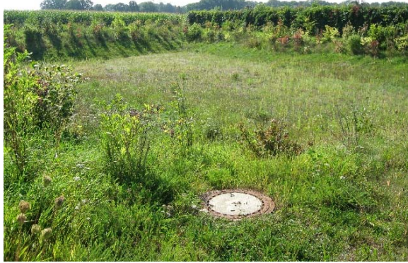
Versickerungsbecken im Südwesten des Baugebiets Gromansfeld, 1. Bauabschnitt; im rechten Bildhintergrund verläuft die mit Efeu und Blauregen begrünte Lärmschutzwand parallel der Eisenbahnlinie (Foto: LANGE GmbH & Co. KG, 09/ 2021)
