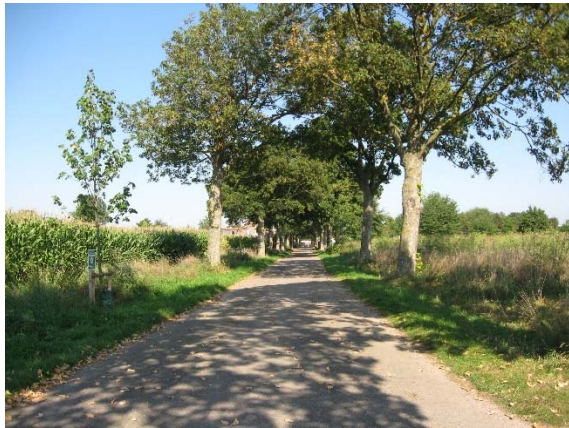
Berg-Ahorn-Allee mit einzelnen Nachpflanzungen entlang der Kempener Straße bei teilweisem Kronenschluss; Blick Richtung Norden (Foto: LANGE GmbH & Co. KG, 01/ 2022)
