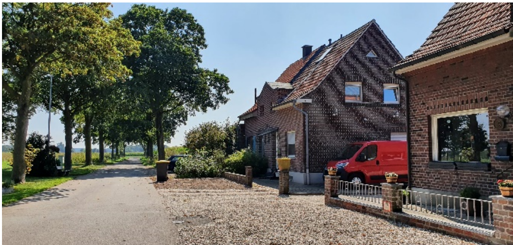
die beiden Doppelhäuser an der Kempener Straße 36/ 38 (rechts im Bild) und 40/ 42 (in der Bildmitte), Blick Richtung Süden (Foto: LANGE GmbH & Co. KG, 09/ 2021)
