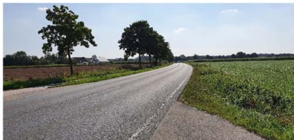
L 3632 auf Höhe der Ackerwegeinmündung Höhe Baugebiet Ackermansfeld
